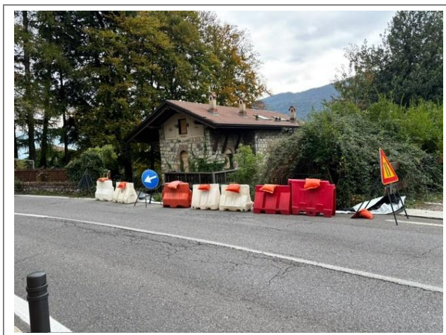
Foto B.3 – Vista dalla direzione opposta: sequenza discontinua di barriere mobili in plastica di diversa tipologia, segnale di passaggio obbligatorio e cartello di pericolo; telo e materiali a terra in corrispondenza del crollo.
