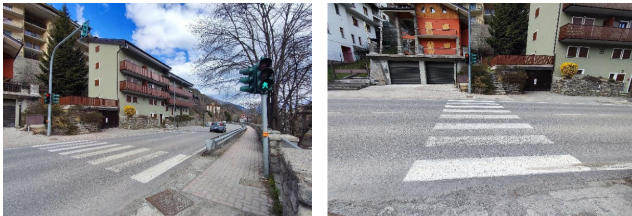
A16 - S. Pietro, attraversamento pedonale sulla S.S.39, all'incrocio con via Pineta: semaforo senza avviso sonoro per i non vedenti, pavimentazioni loges, cartelli di segnalazione dell'attraversamento, sbarco in pendenza, etc. ...
