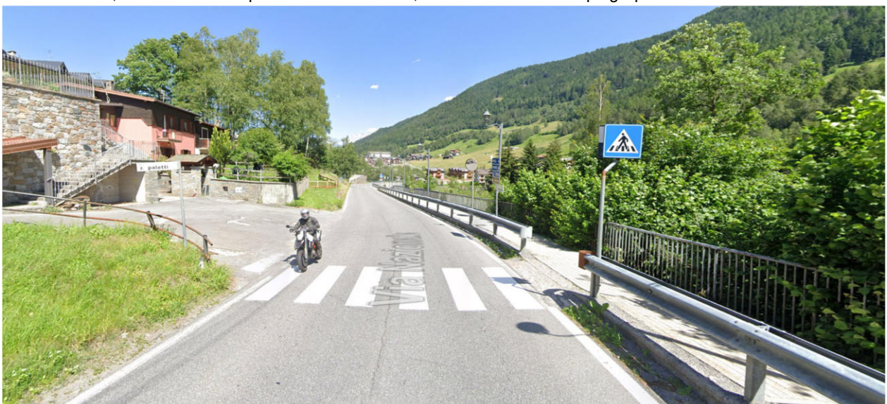
A17 - S. Pietro, attraversamento pedonale sulla S.S.39, all'incrocio con via Paletti
