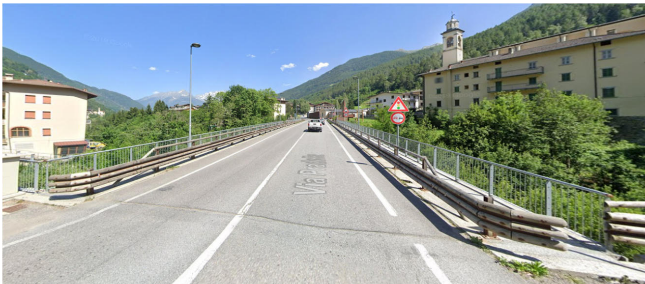
S.S.39, Pisogneto: il nuovo ponte su via Pradella
