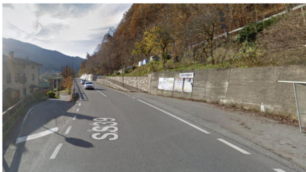
S.S.39, via Lombro e via Panoramica
