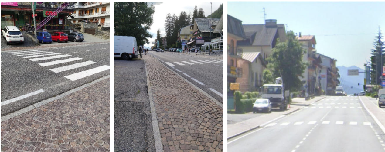
A07 - S. Pietro, attraversamenti pedonali su via Nazionale - S.S.39
