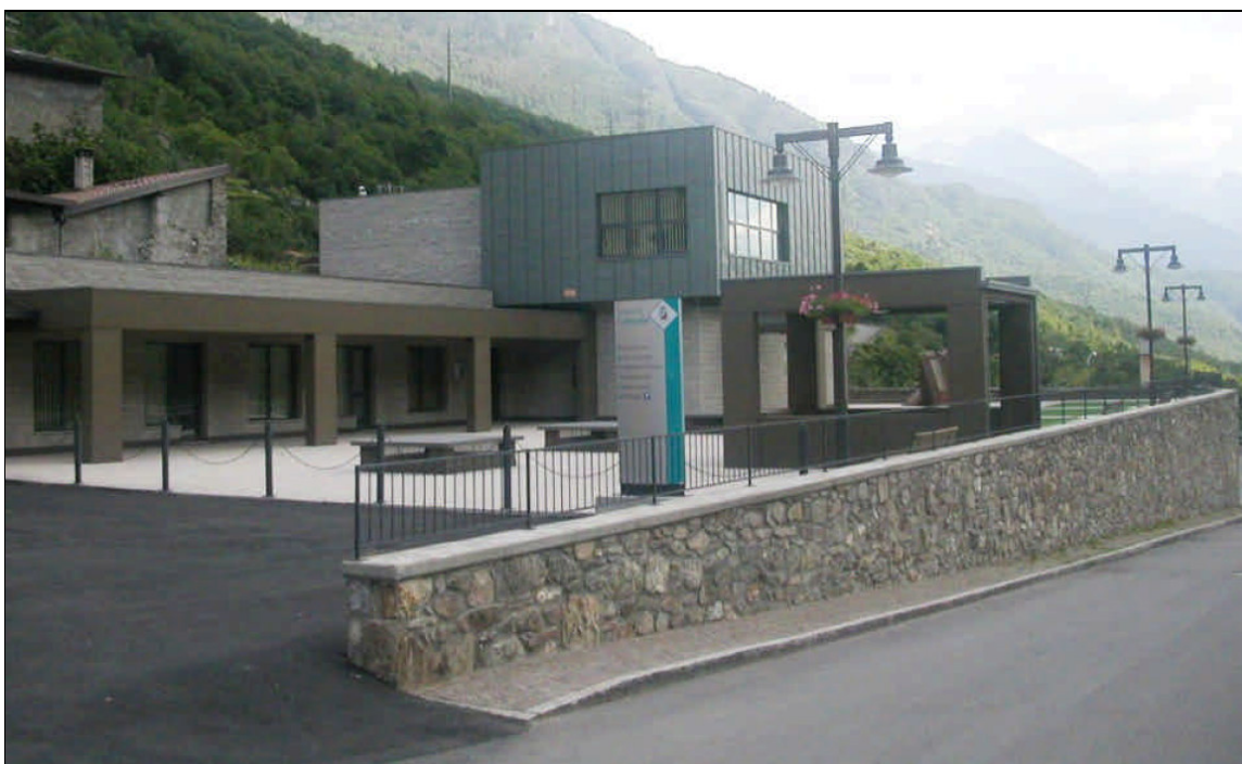
Figura 82: Centro polifunzionale Frazione di Grevo
