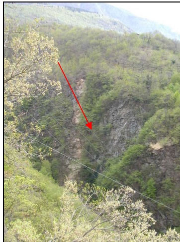
Figura 19: Fenomeni erosivi e franosi di scivolamento superficiale in depositi eluvio colluviali a valle del Bacino del Poja
