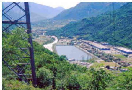
Figura 73: Vasca di accumulazione Sellero
