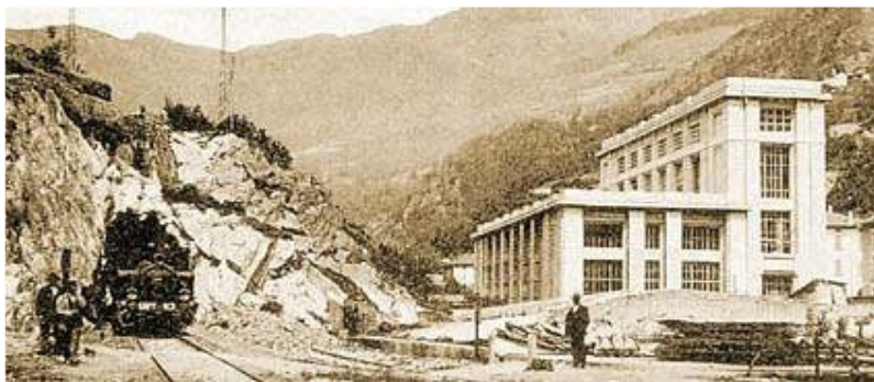
Figura 95: ex centrale elettrica Bresciana
