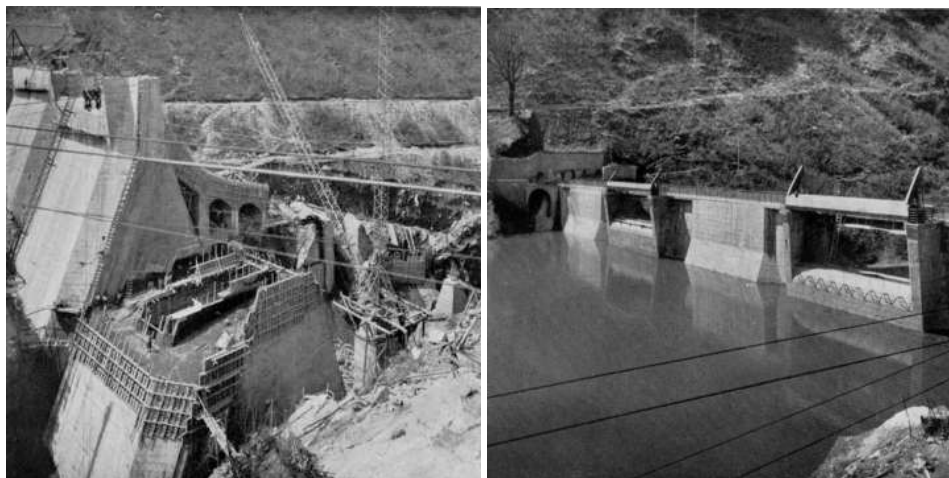
Figura 68: Diga del Poggia in costruzione e Invaso del Poggia
