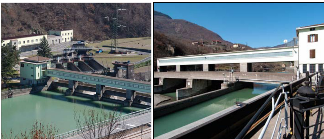
Figura 69: Centrale idroelettrica EDISON di Cedegolo
