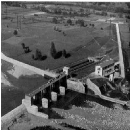
Figura 67: Opera di presa sul Fiume Oglio
