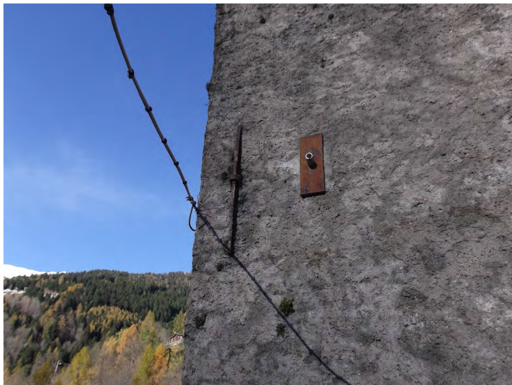
Particolare dell'ancoraggio dei tiranti di consolidamento delle volte:
