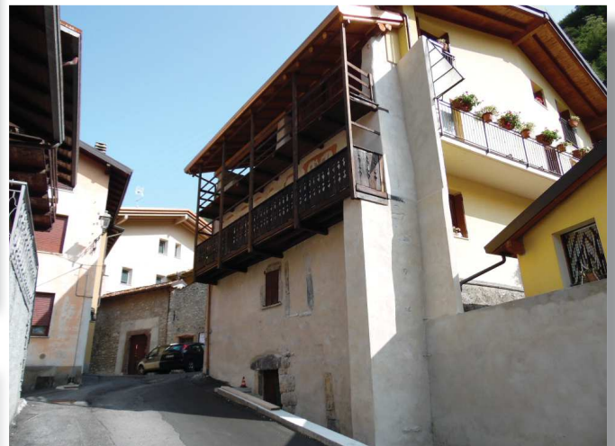
Fabbricato ristrutturato e allargamento strada
