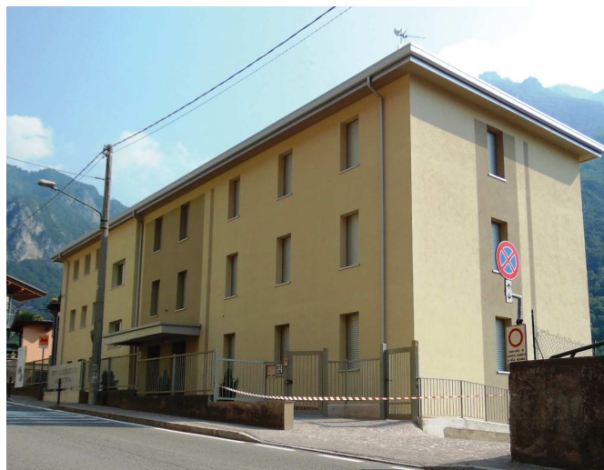
L'edificio scolastico riqualificato
