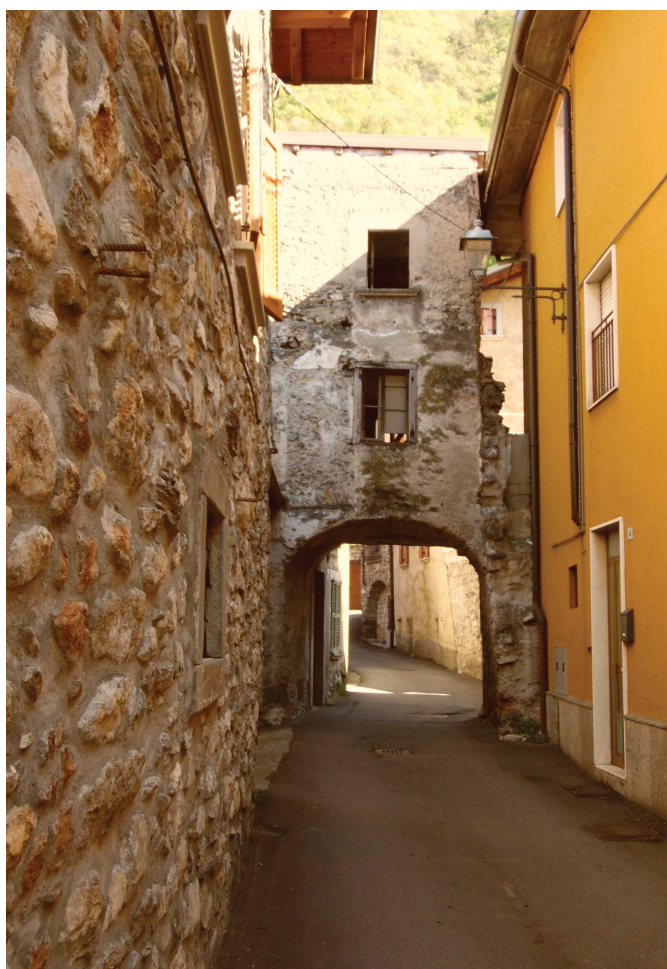
Messa in sicurezza di via Montello
