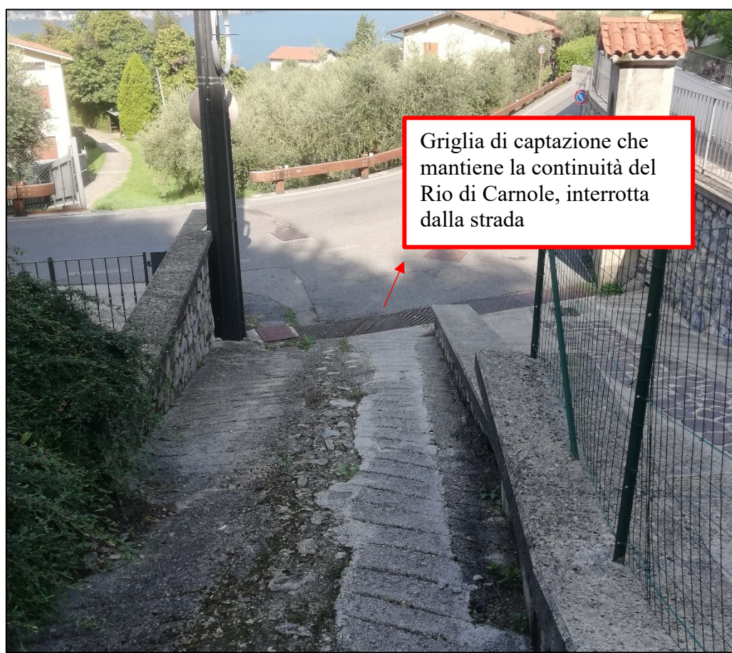
Figura 11: Rio di Carnole – Criticità idraulica rilevata.
