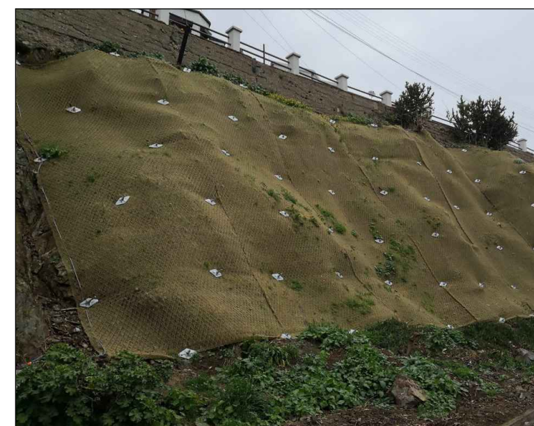
VISTA VERSANTE PROTETTO CON RETE IN ADERENZA TIPO TECCO
