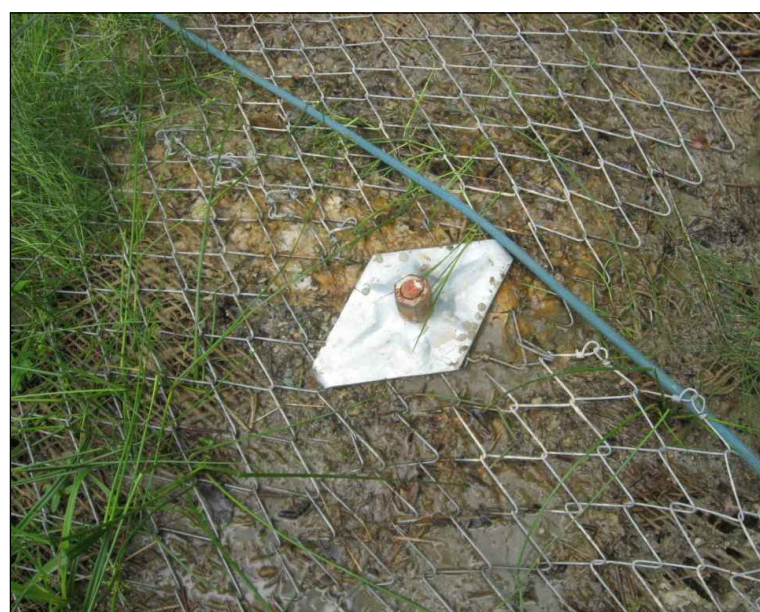
TIPOLOGIA PIASTRA DI ANCORAGGIO
