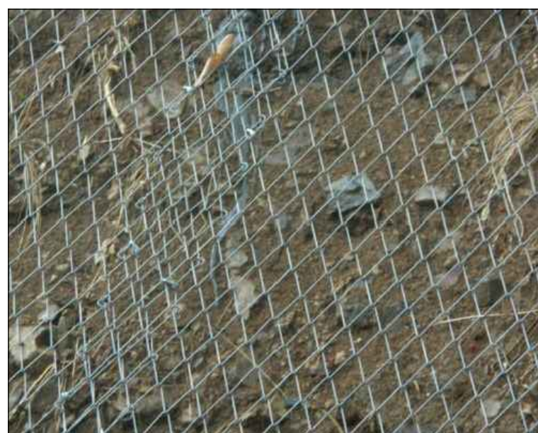
DETTAGLIO RETE IN ADERENZA TIPO TECCO
