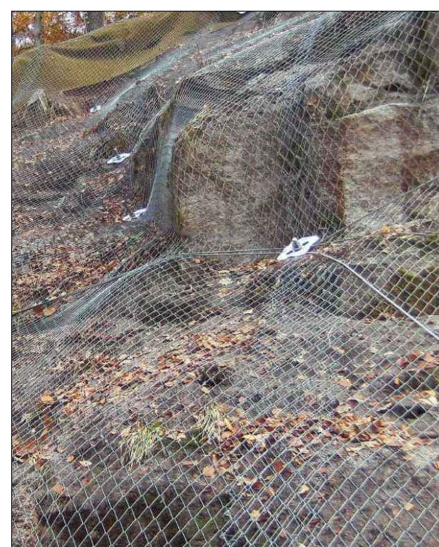
TIPOLOGIA RETE IN ADERENZA TIPO TECCO
