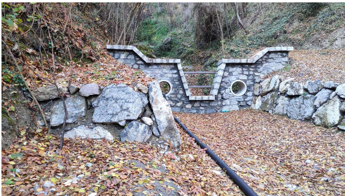
2022 - Torrente Budrio – Darfo B.T. – Realizzazione briglia filtrante e scogliere
