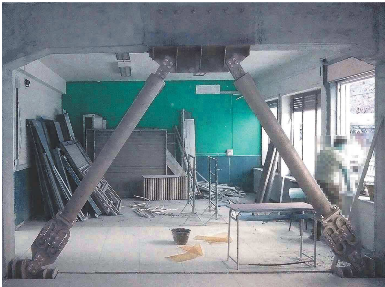
Installazione di controventi dissipativi
