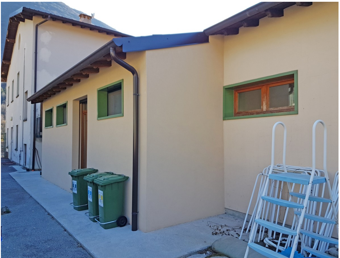
ristrutturazione e ampliamento di edificio comunale di coresidenza "Casa Comune" Progetto esecutivo _ Relazione generale
