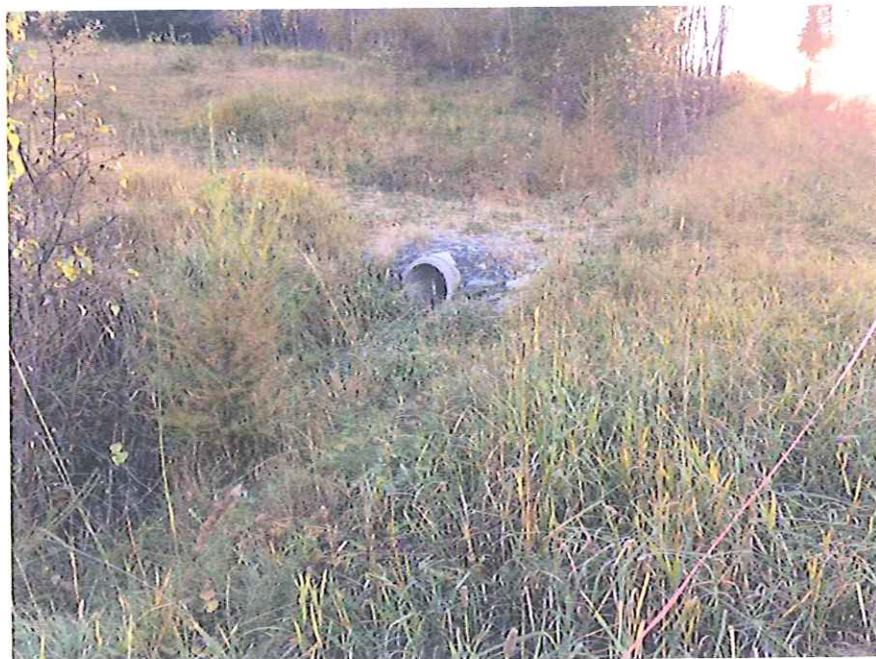
Foto 2.2: attraversamento accesso rurale di q. 1175 m slm con tubazione cls diam. 500 mm
