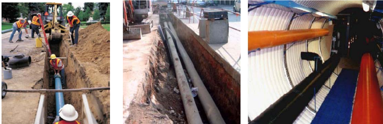
Figura 31: Esempi di posa delle infrastrutture a rete
