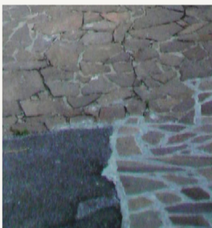
Discontinuità dei tipi di pavimentazione
