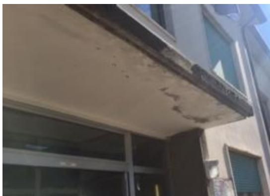
La struttura metallica di sostegno della porta di ingresso della scuola non è saldamente ancorata.
