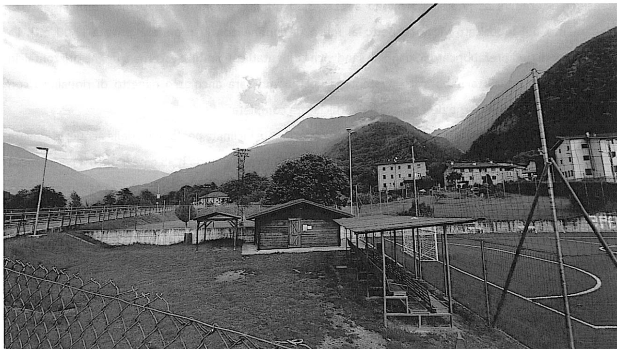
Fabbricati a servizio campo sportivo: stato di fatto
