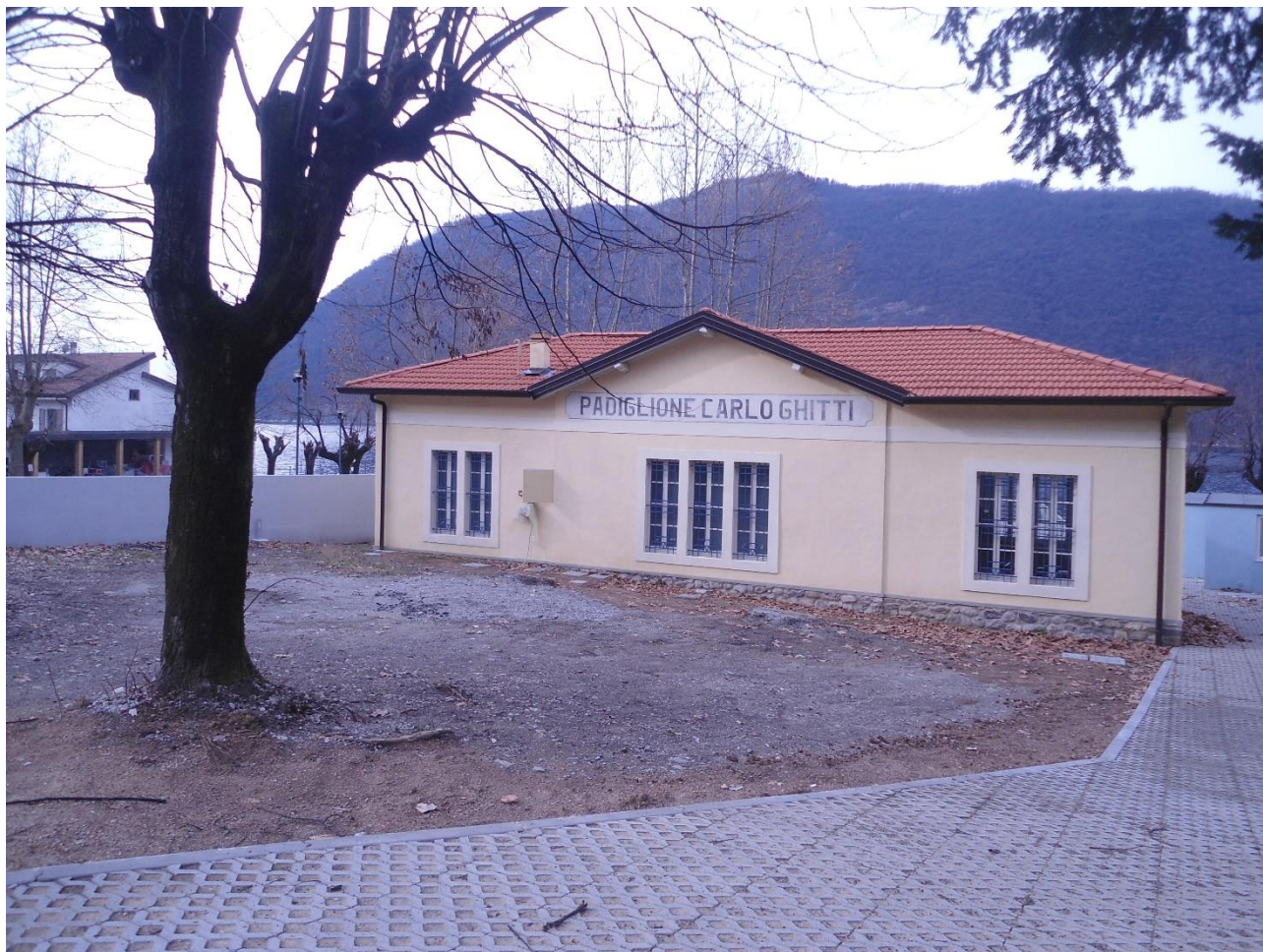
Esterno – Prospetto Est
