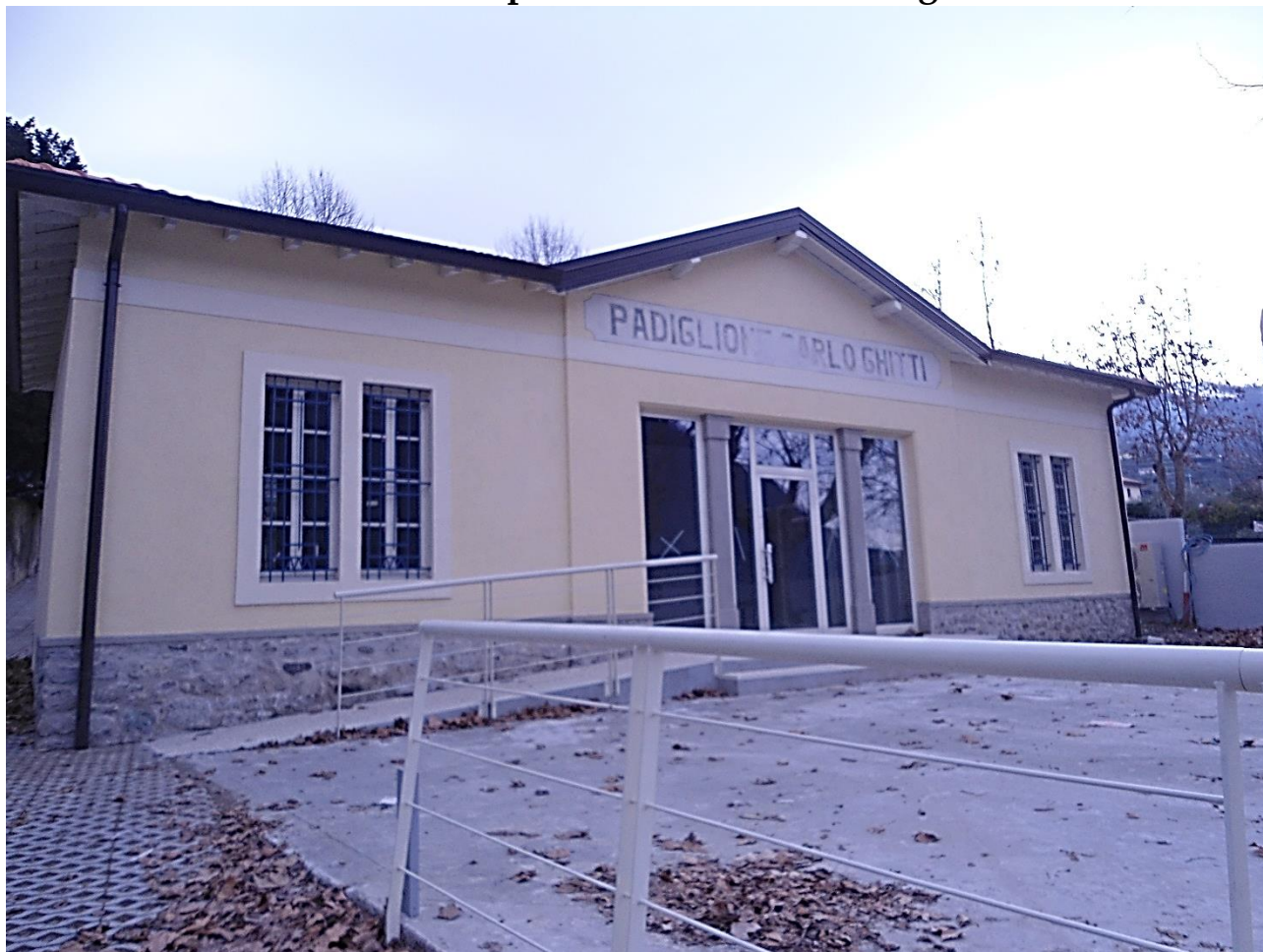
Esterno – Prospetto Est
