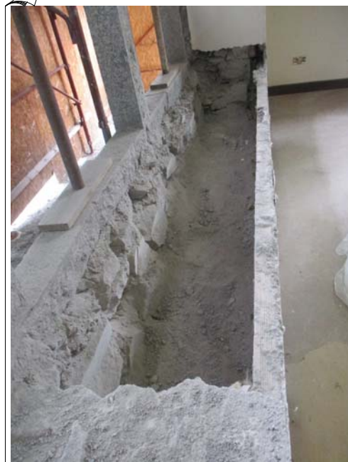
Demolizione avanzata apertura fronte Est. by Arch. Sergio Ghirardelli (DL)
