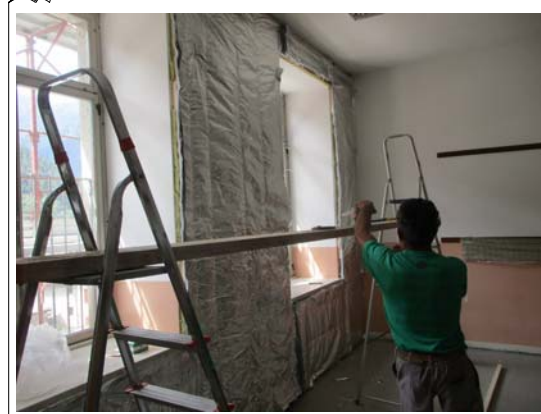
realizzazione coibentazione contropareti by Arch. Sergio Ghirardelli (DL)
