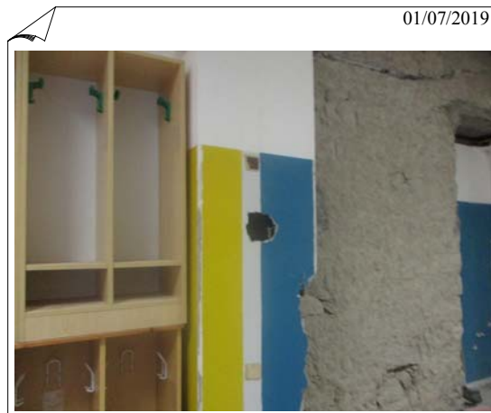
indagine lesene di appoggio trave T1 piano terra. by Arch. Sergio Ghirardelli (DL)
