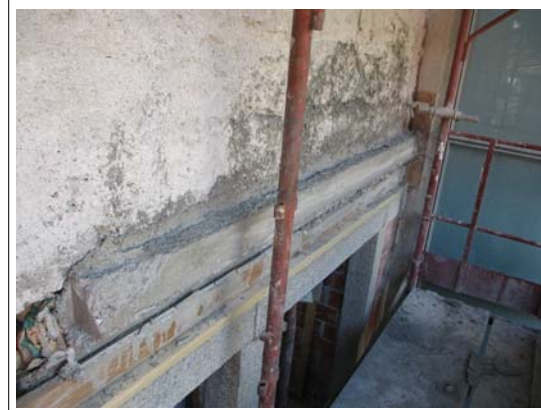
scassero getto trave apertura Est T2I new eseguita in due tempi by Arch. Sergio Ghirardelli (DL)
