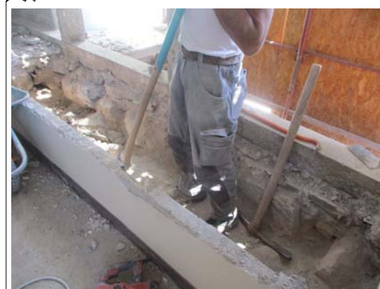
Demolizione davanzale per realizzazione trave F1. by Arch. Sergio Ghirardelli (DL)
