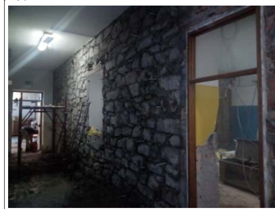
Superficie della parete sottoposta a idropulizia e formazione diatoni. by Arch. Sergio Ghirardelli (DL)
