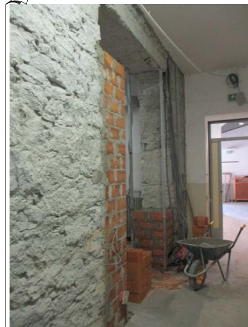
Costruzione rinforzo stipiti. by Arch. Sergio Ghirardelli (DL)
