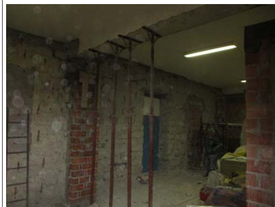
Piedritti di rinforzo sala polifunzionale by Arch. Sergio Ghirardelli (DL)
