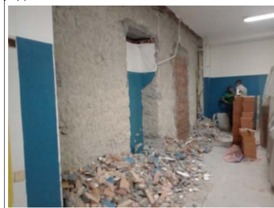
Demolizione contro parete in mattoni forati. by Arch. Sergio Ghirardelli (DL)
