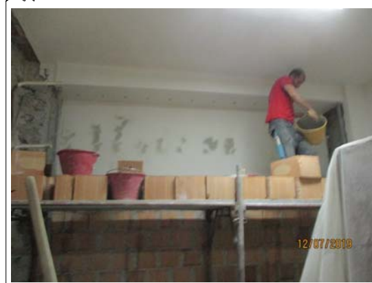
Costruzione muratura M1. by Arch. Sergio Ghirardelli (DL)
