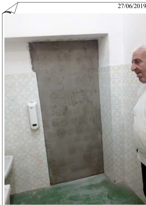
Riempimento nicchia del bagno al piano terra. by Arch. Sergio Ghirardelli (DL)
