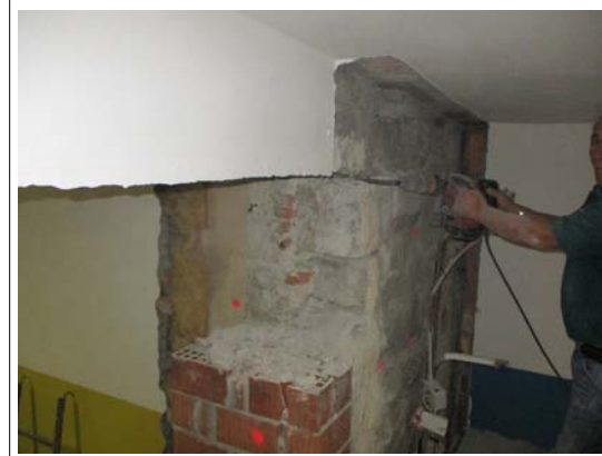
realizzazione fori per intonaco armato by Arch. Sergio Ghirardelli (DL)
