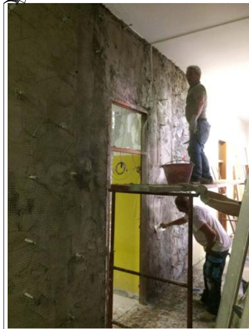
Posa in opera della rete di placcaggio delle pareti. by Arch. Sergio Ghirardelli (DL)
