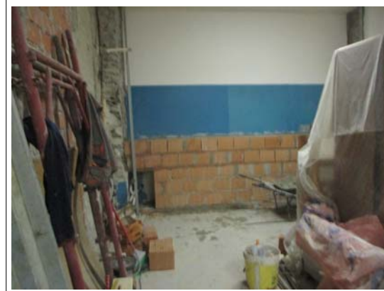
Costruzione muratura M1. by Arch. Sergio Ghirardelli (DL)
