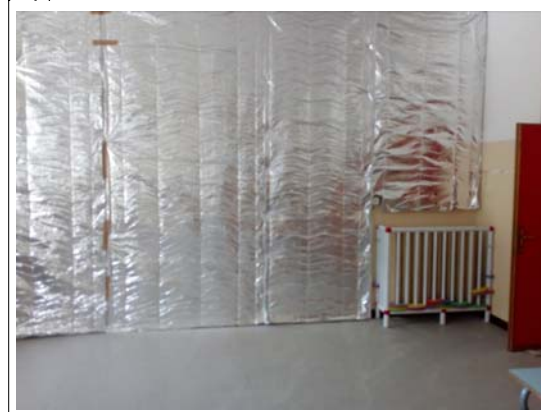
realizzazione isolamento contropareti by Arch. Sergio Ghirardelli (DL)
