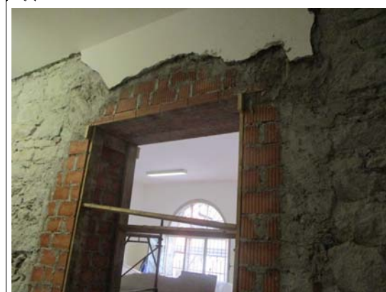
Architrave apertura verso refettorio. by Arch. Sergio Ghirardelli (DL)
