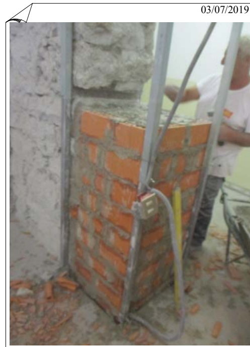
Costruzione stipiti aperture piano terra. by Arch. Sergio Ghirardelli (DL)
