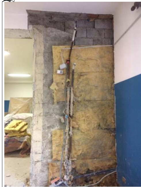
Lesena di appoggio trave T1 - piano terra. by Arch. Sergio Ghirardelli (DL)
