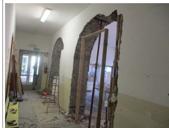
Demolizione stipite aperture piano terra. by Arch. Sergio Ghirardelli (DL)
