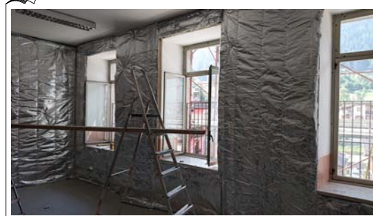
realizzazione coibentazione contropareti by Arch. Sergio Ghirardelli (DL)
