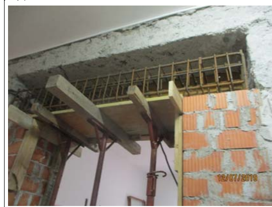
Ferri di armatura architrave di rinforzo. by Arch. Sergio Ghirardelli (DL)
