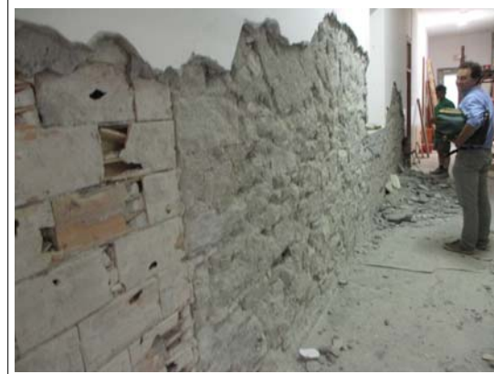
rimozione intonaco. by Arch. Sergio Ghirardelli (DL)
