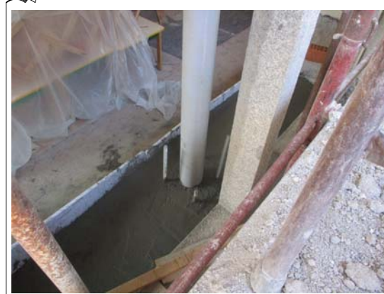
Getto che ricopre la piastra di base della colonna metallica by Arch. Sergio Ghirardelli (DL)
