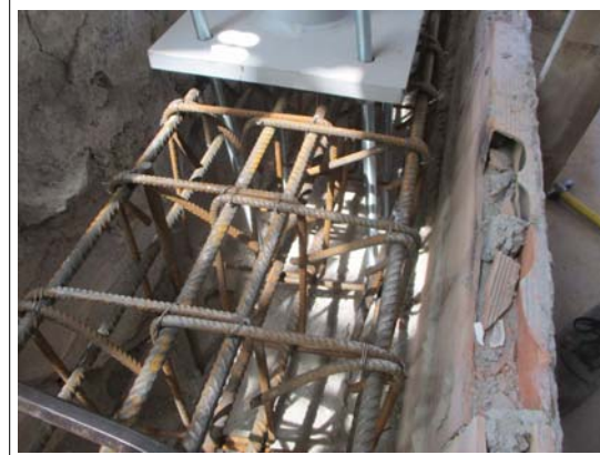
gabbia di armatura trave F1 corretta by Arch. Sergio Ghirardelli (DL)
