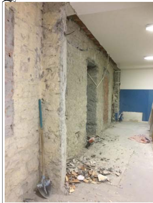
Rimozione intonaco parete salone piano terra. by Arch. Sergio Ghirardelli (DL)
