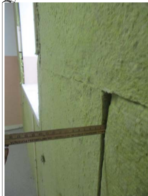
Verifica spessore isolamento. by Arch. Sergio Ghirardelli (DL)
