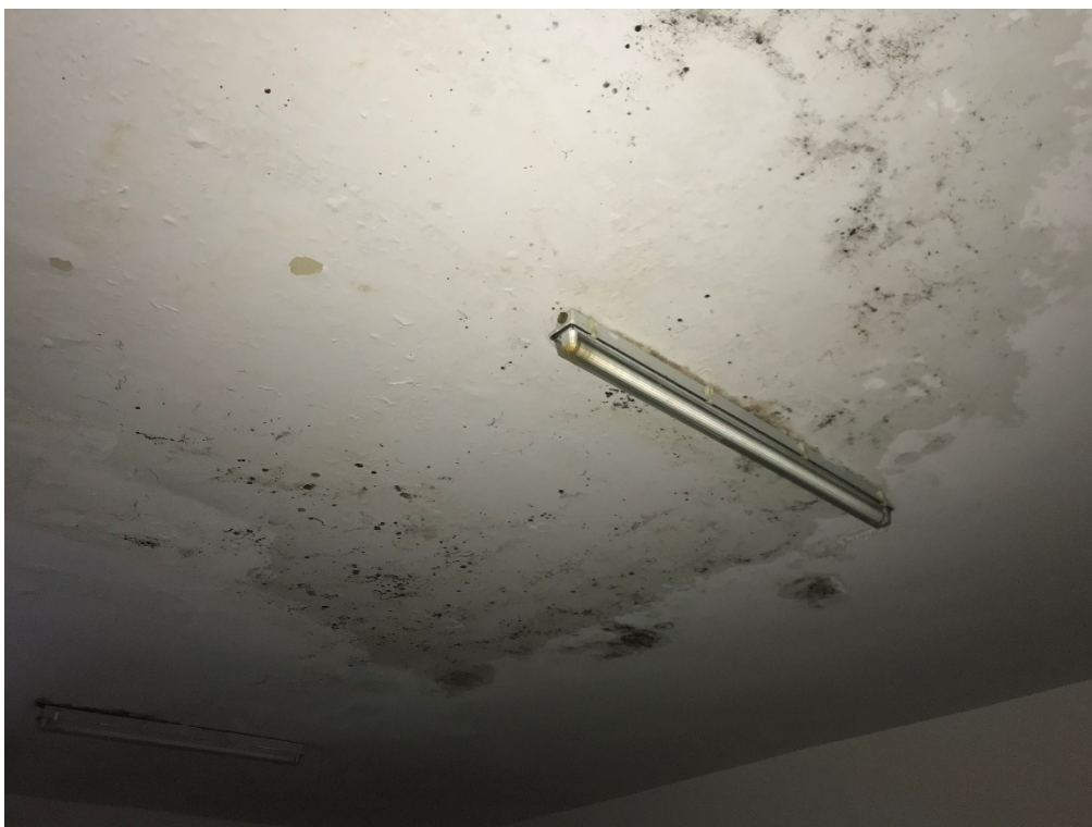
(Infiltrazione soffitto locale V2 | PT)
