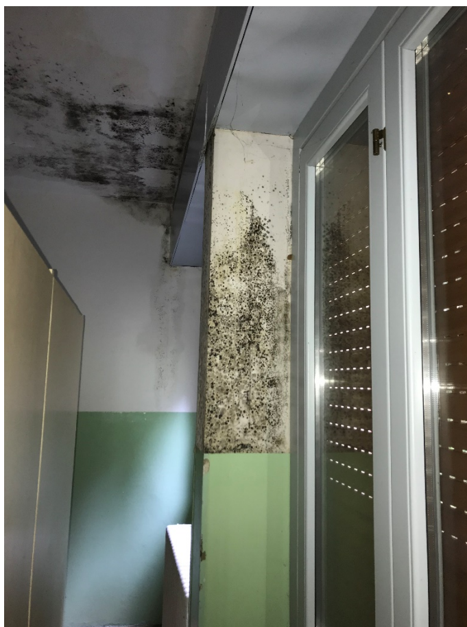
(Infiltrazione soffitto a parete perimetrale locale V2 | PT)
