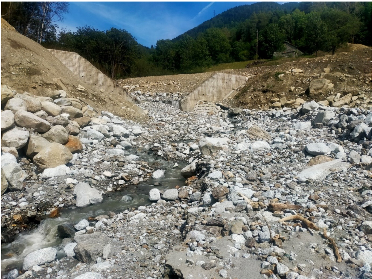
Materiale sedimentato a valle della briglia, nella zona di espansione
