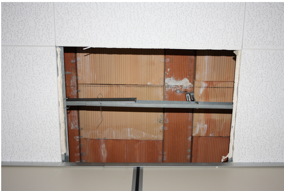
Fotografia nr.03 - Particolare solaio in latero-cemento
