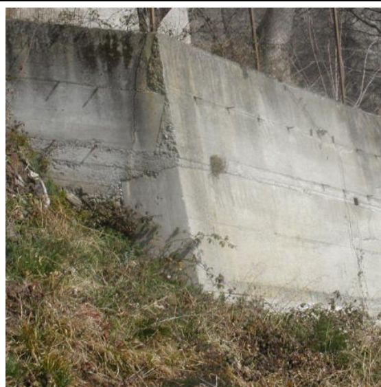
Foto 3. Muri in cls posti a monte dell'intervento in progetto presentanti alcune lesioni
