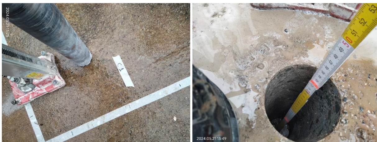
Fasi di esecuzione dei carotaggi
