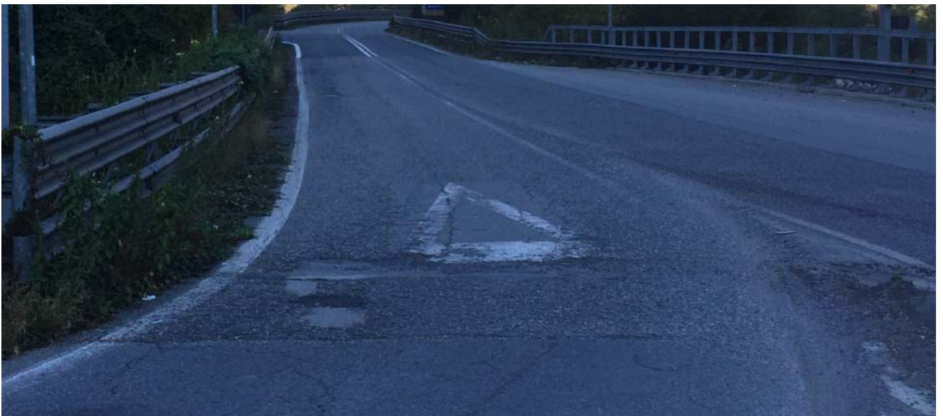
Figura 8 ammaloramenti bretella di uscita SS 42
