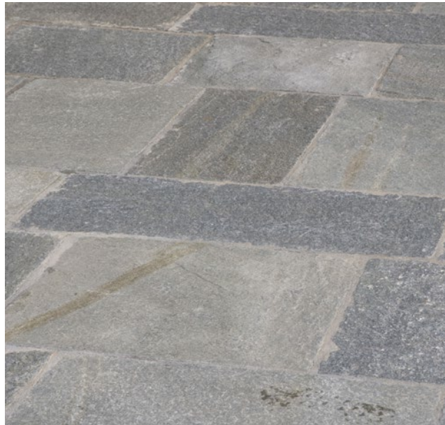
Pavimentazione in luserna
