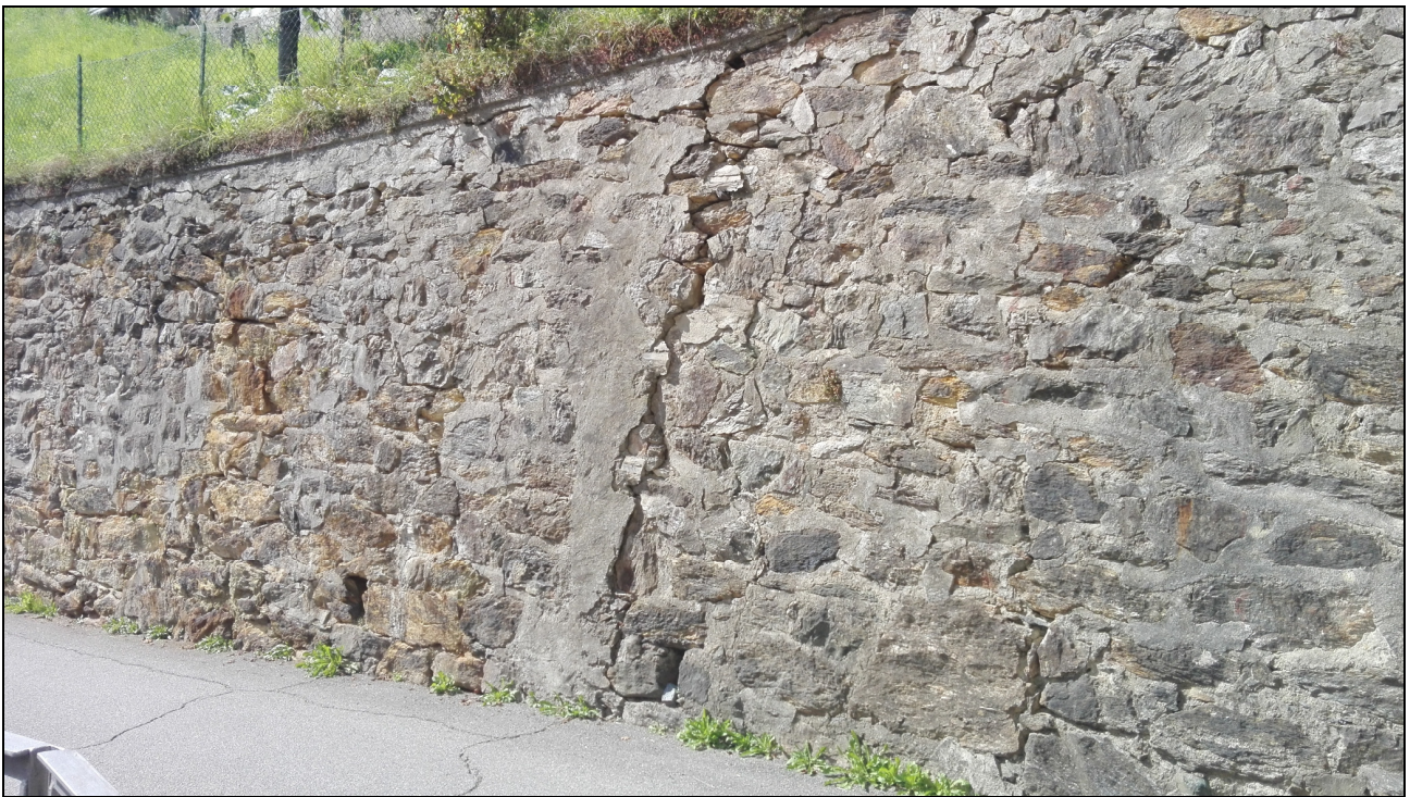
Fessurazione presente sulla muratura
