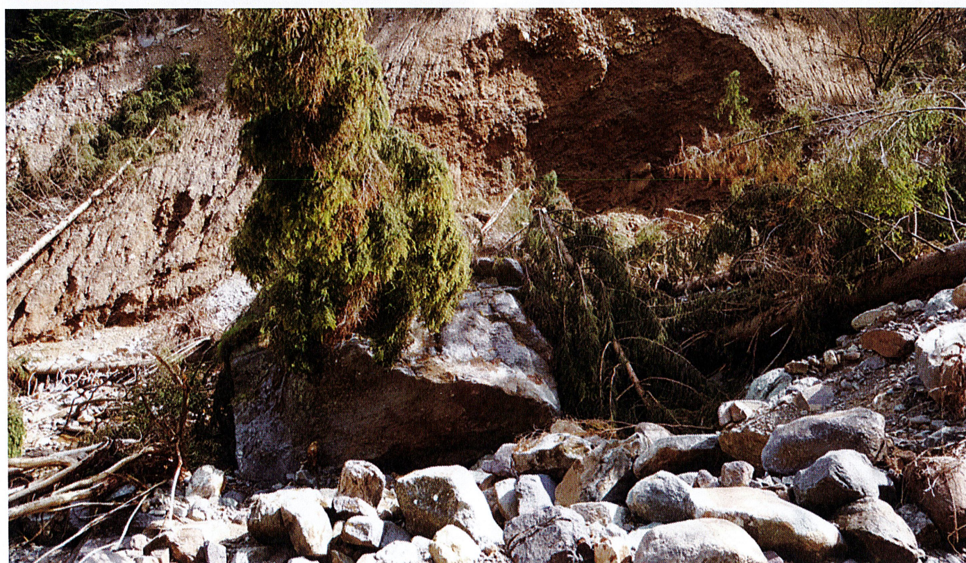
Il grosso masso che è stato utilizzato come elemento di vincolo per lo spostamento dell'asta torrentizia.
