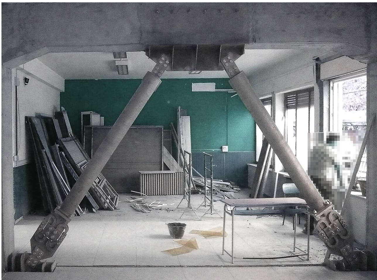
Installazione di controventi dissipativi
