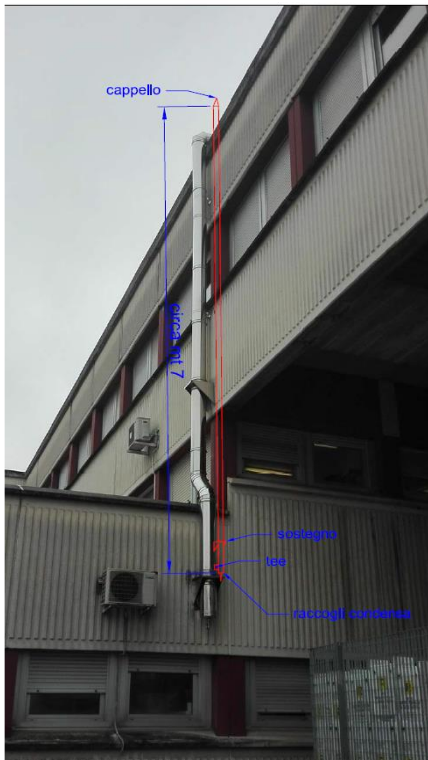
Prospetto espulsione canna di espulsione
