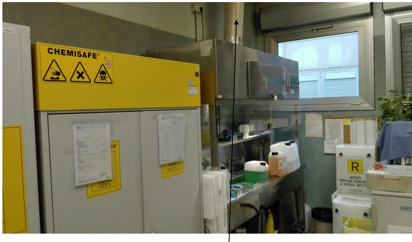
Particolare cappa con ventilatore da disattivare
