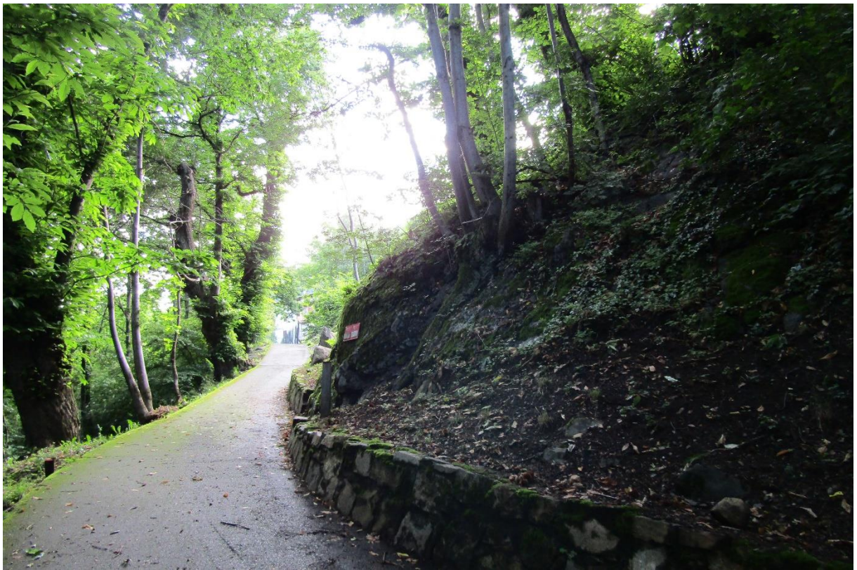
Area di variante ovest: vista di parte dell'affioramento roccioso posto a valle dell'are.
