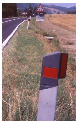
Figura 11: L'uso dei catadiottri si fonda sull'abitudine della fauna a spostarsi prevalentemente dal crepuscolo all'alba, abitudine ampiamente documentata dai dati raccolti nel corso di numerose indagini effettuate sia in Italia, sia all'estero
