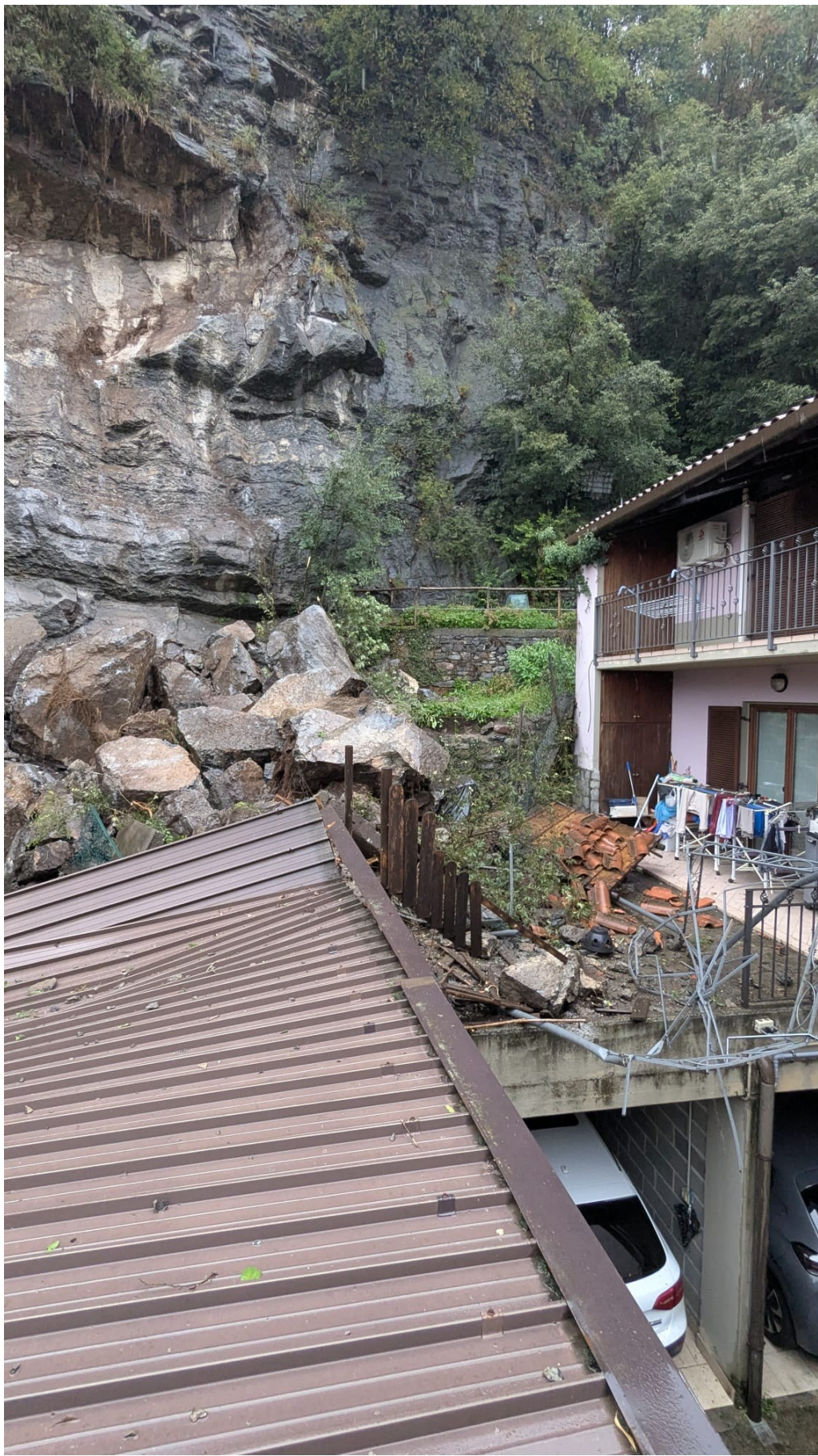
Materiale franato in via Pittor Nodari con danneggiamento accessori presenti nell'area di pertinenza dell'abitazione evacuata.
