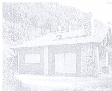
Unita residenziale in Cividate Camuno
