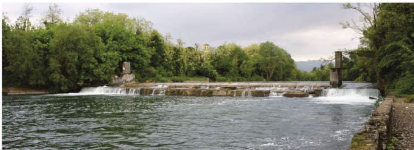
Stato di fatto attuale della traversa
