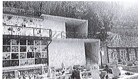
Ampliamento del cimitero di Niardo
