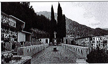
Ampliamento del cimitero di Niardo
