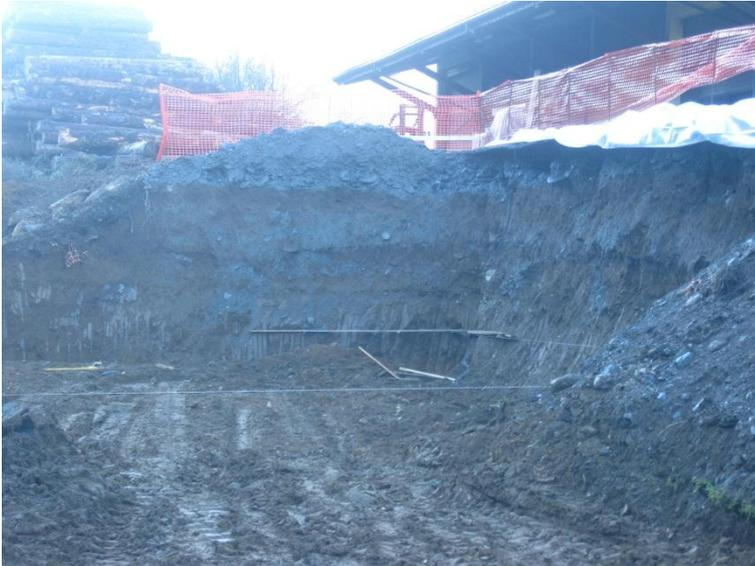
Come osservato dallo scavo eseguito nelle aree immediatamente a monte del settore d'indagine, i depositi della porzione distale della conoide alluvionale sono costituiti da terreni a granulometria medio fine, in genere alterati di colore marrone, con inglobati blocchi e ciottoli. I depositi presentano un'elevata percentuale di frazione argillosa, derivante da processi di alterazione dei depositi originari (ricchi anche di materia
