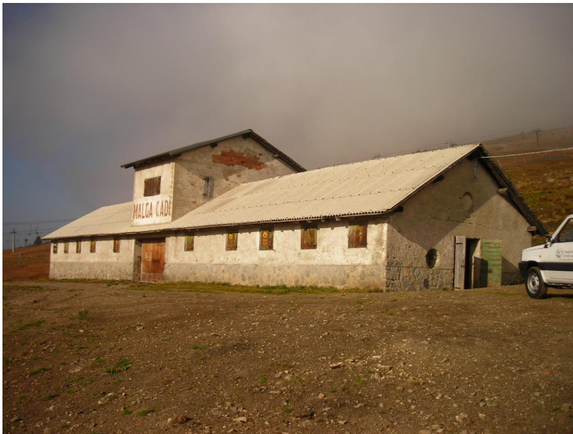
Il fabbricato prima del crollo (anno 2009)
