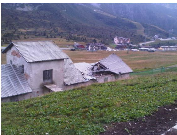
Il crollo ha compromesso la staticità della parte ovest del fabbricato (anno 2011)
