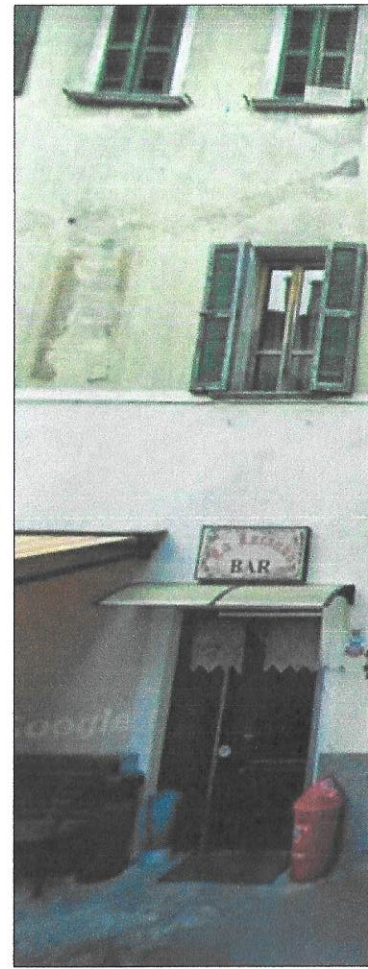
FOTOGRAFIA A - vista dal civico 92 della Via
