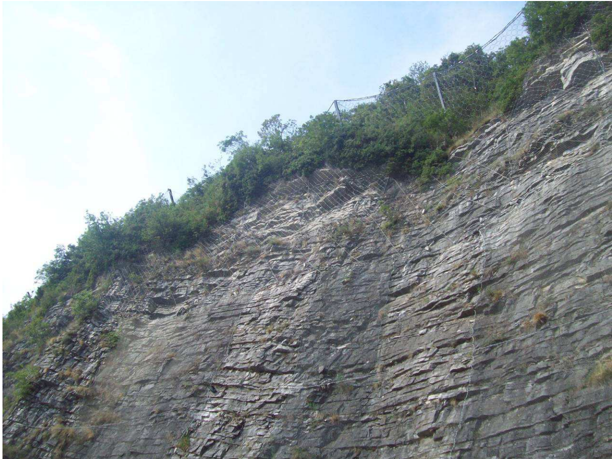
Foto 2: particolare area con interventi di barriere e reti paramassi esistenti in questo settore dell'isola
