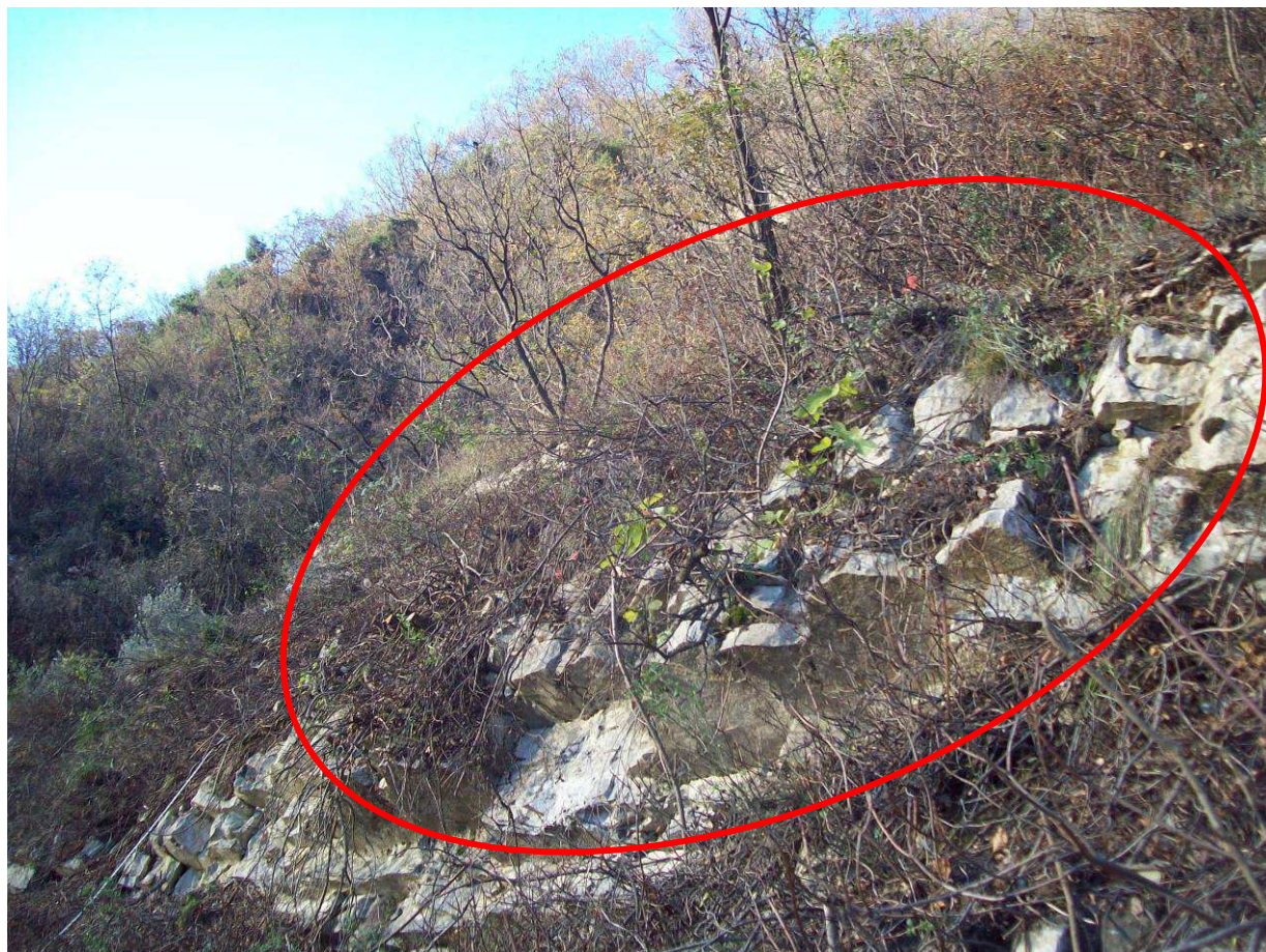
Foto 2 : 'Tetti' rocciosi al ciglio superiore della scarpata lungo strada, una delle numerose zone di alimentazione dei crolli
