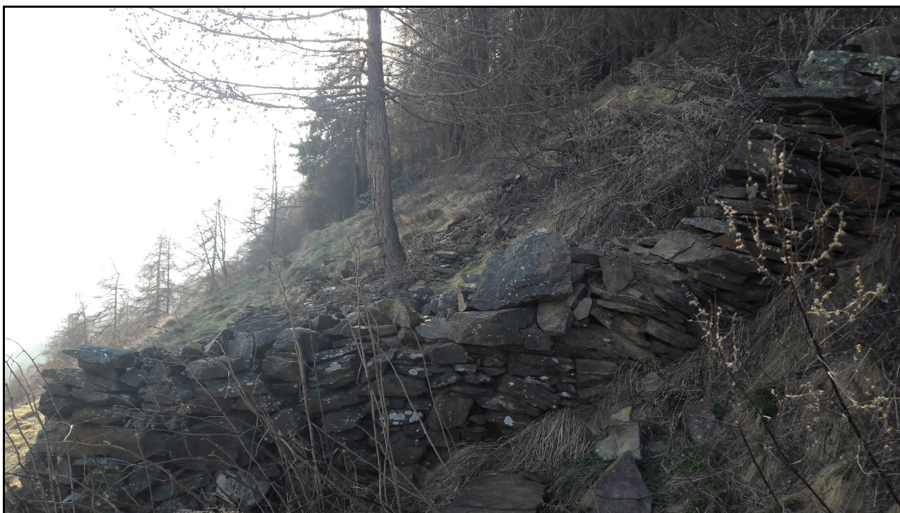
Vista da lato est
