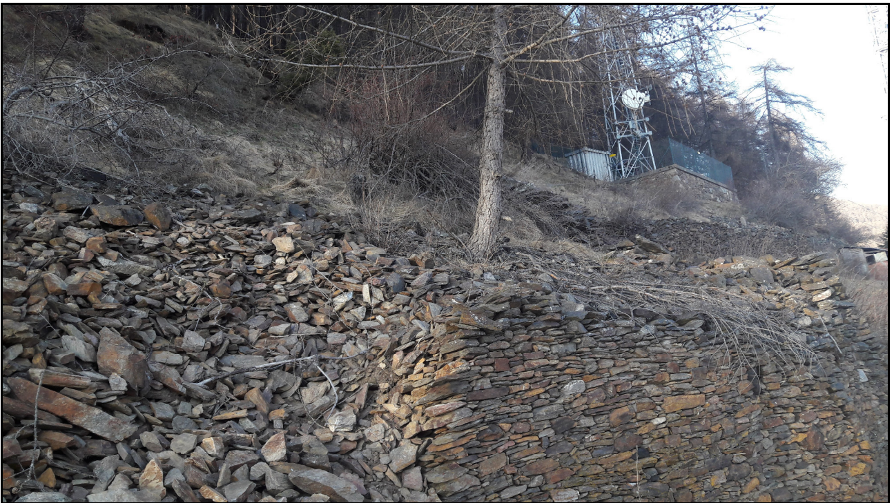
Vista da lato sud-ovest
