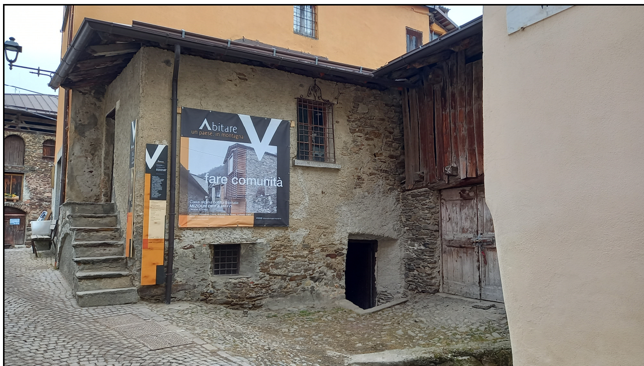
Vista da lato ovest
