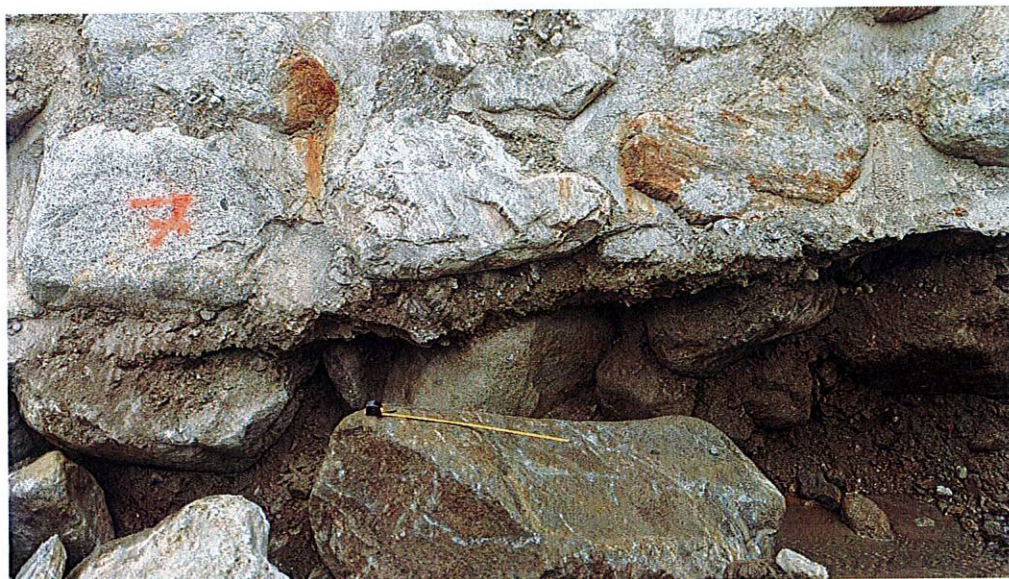
Foto 3 (14.07.2026) — Intervento di sottomurazione: massi di grande pezzatura a colmatura della trincea. Riferimento metrico da 1,00 m.
