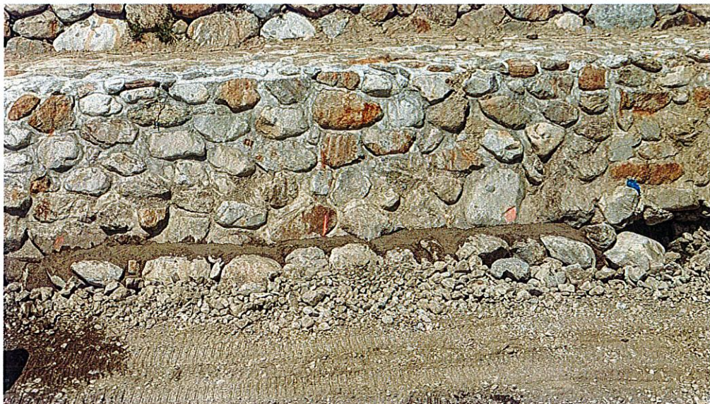
Foto 1 (10.07.2026) — Scogliera in destra idraulica a monte della passerella: paramento murario e piede di fondazione reso ispezionabile dall'abbassamento del fondo alveo.
