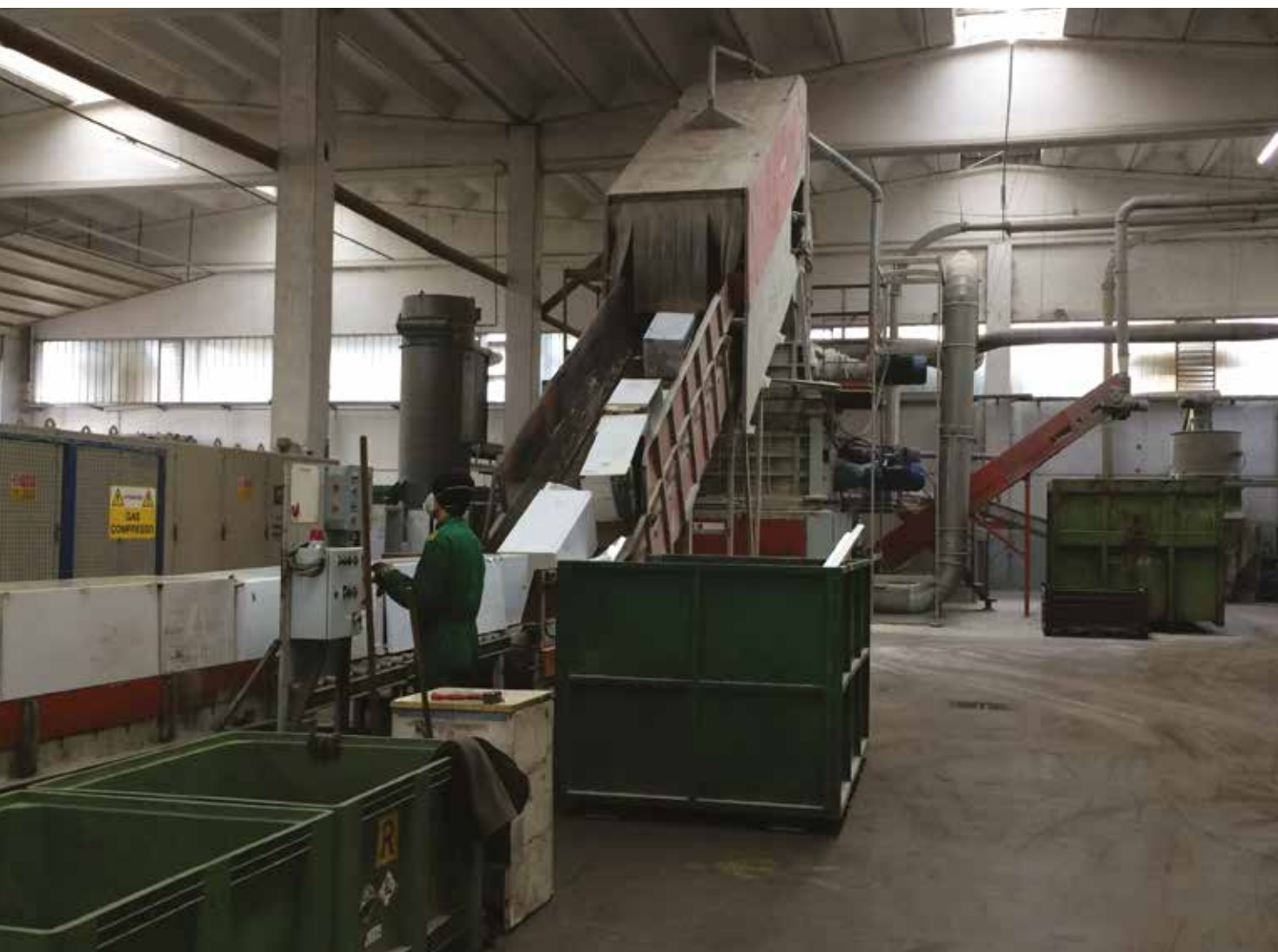
Foto 5.08 Impianto di riciclaggio Fonte MATTM
