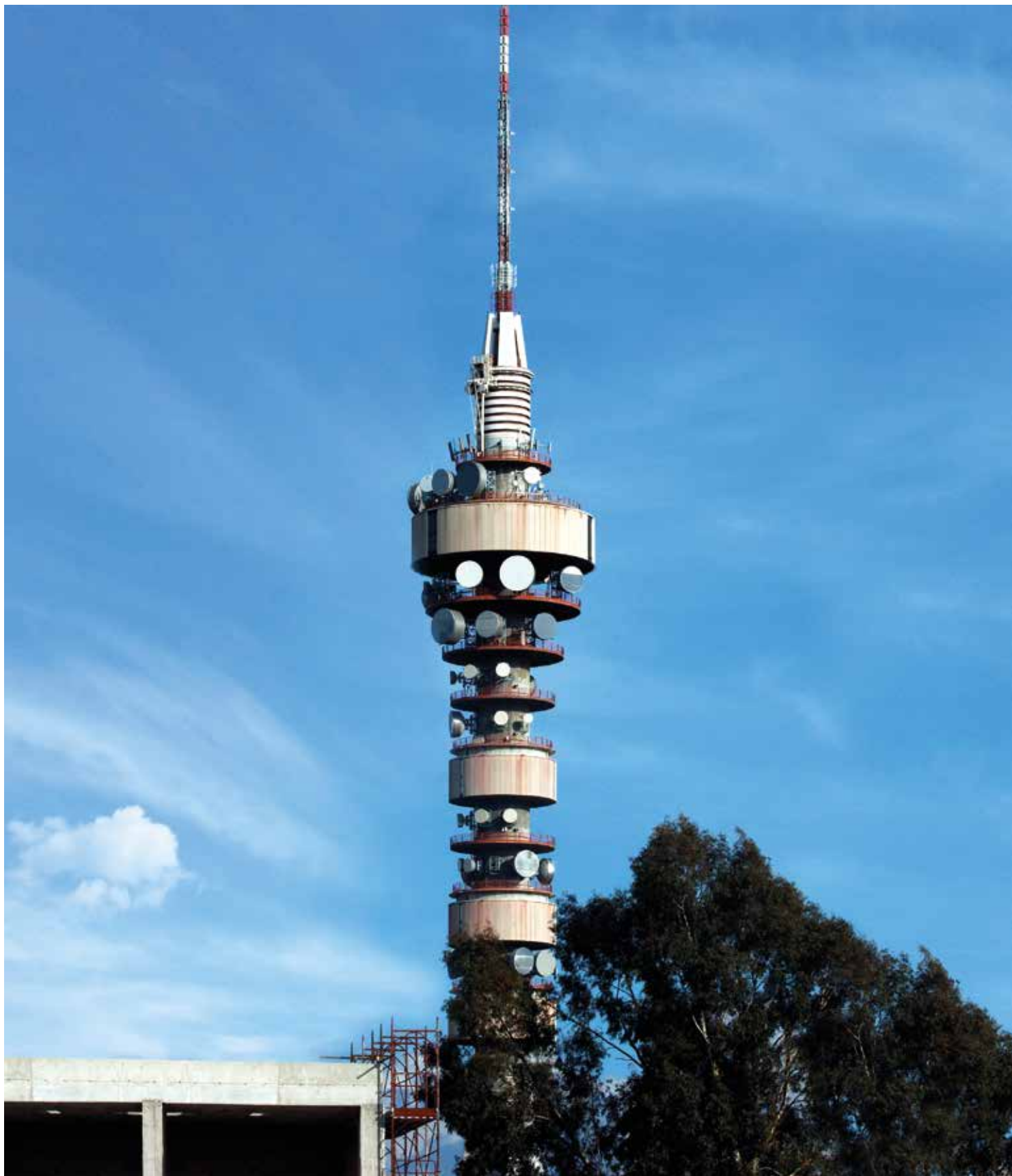
Foto 3.07 Antenna RTV Fonte ISPRA Paolo Orlandi
