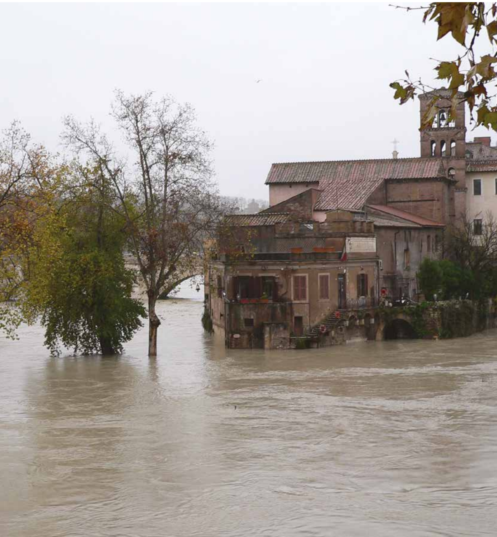
Foto 6.04 Alluvione Fonte ISPRA Franco Iozzoli
