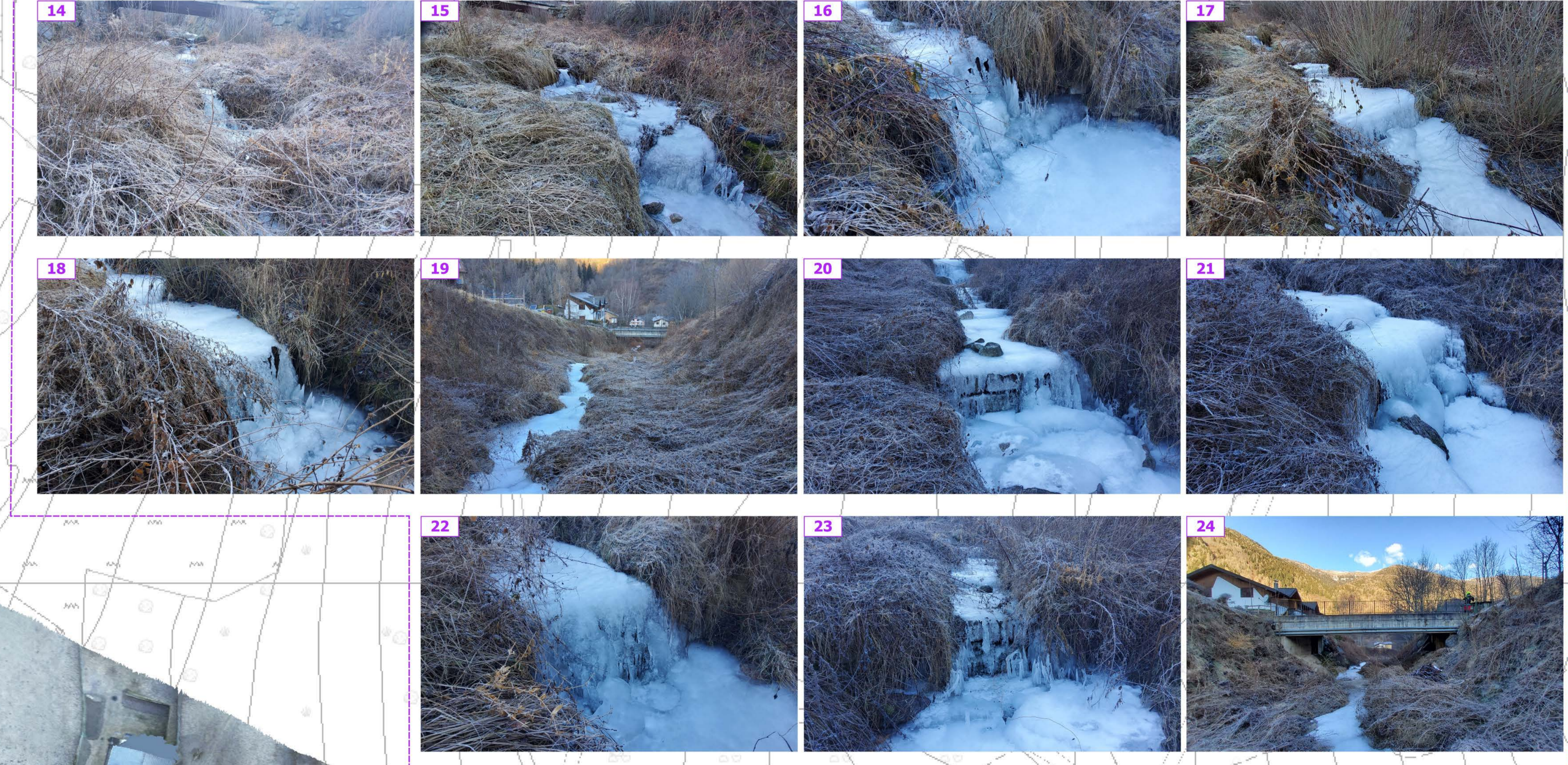
Fotografie del tratto fra il ponte di via Villa e il ponte di via della Scala
