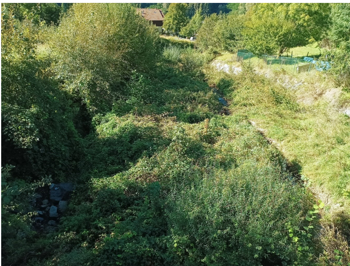
Tratto d'alveo oggetto d'intervento di pulitura della vegetazione.
