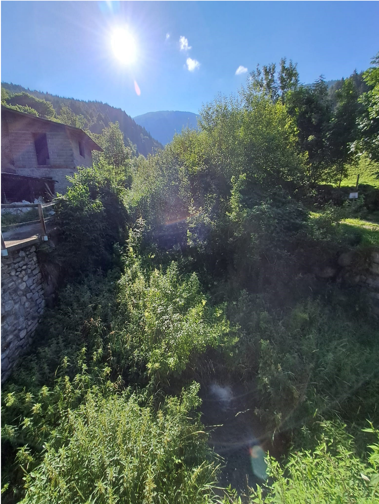
Tratto d'alveo oggetto d'intervento di pulitura della vegetazione ed aree di deposito, al fine del corretto ripristino della funzionalità idraulica del torrente.
