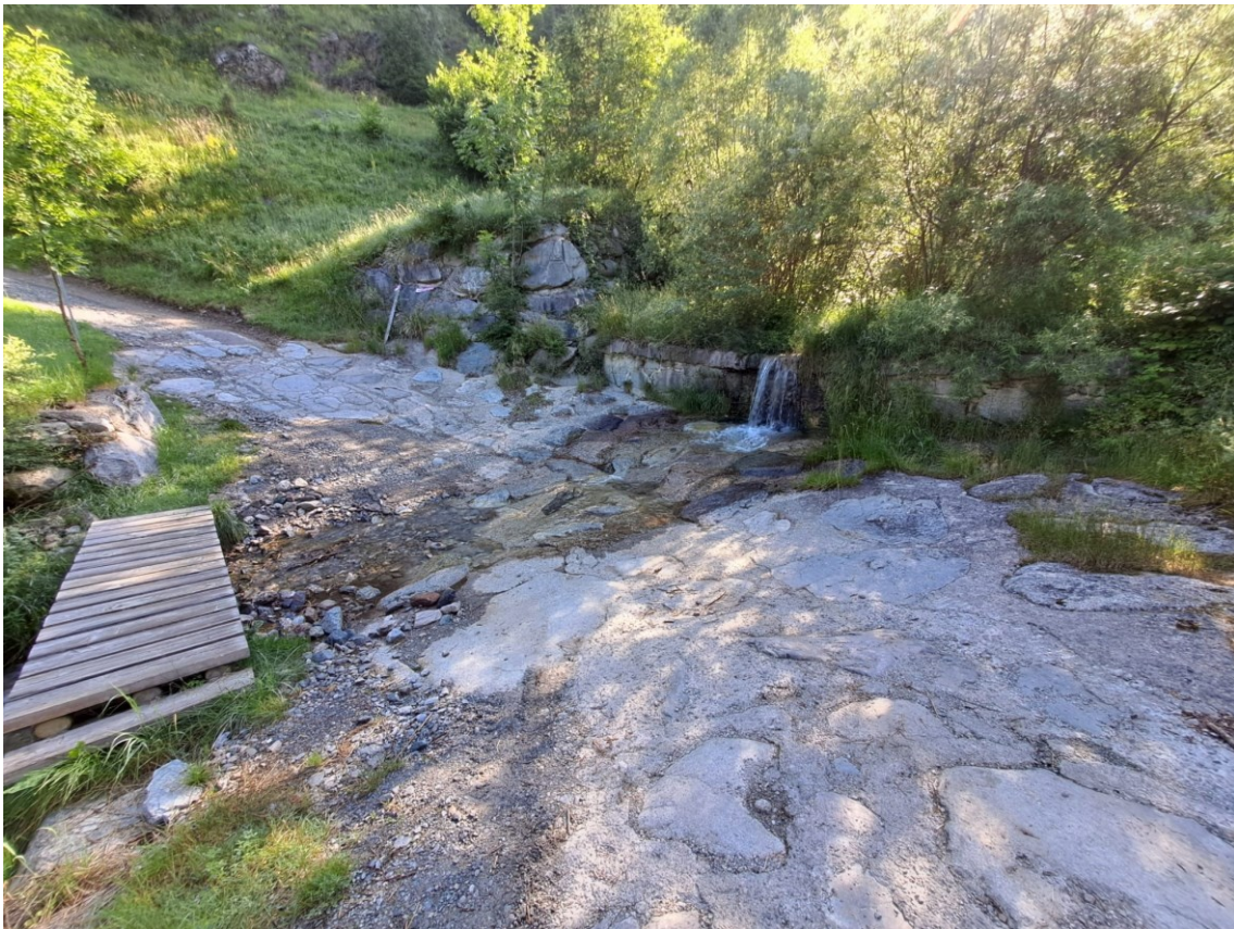
Manutenzione della briglia esistente, pulitura del materiale litoide e vegetale accumulato a monte della briglia, rifacimento del guado in pietra e dell'area di dissipazione a valle della strada.
