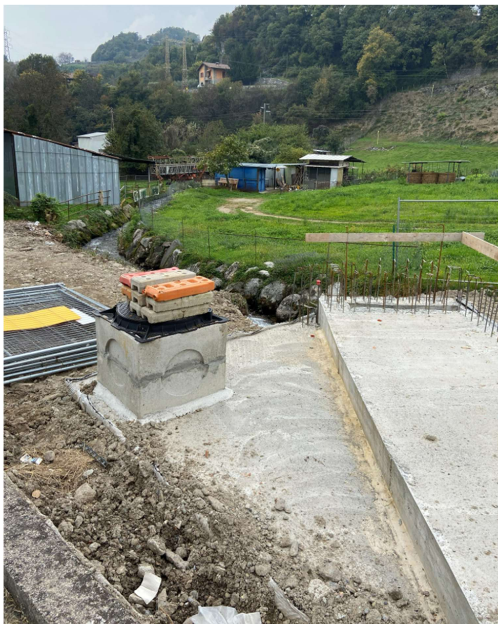
Figura 29. Organo di regolazione in fase di realizzazione in comune di Berzo Inferiore
