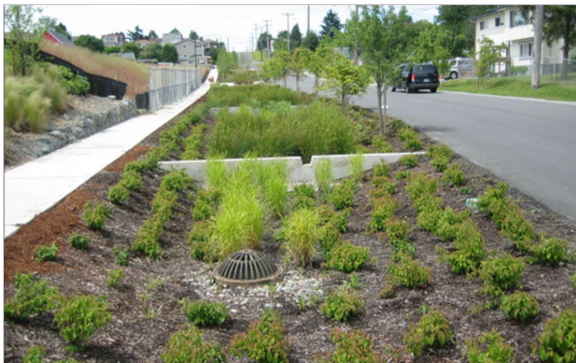
Figura 39. Giardini della pioggia e fossi vegetati per la raccolta e smaltimento delle acque di deflusso
