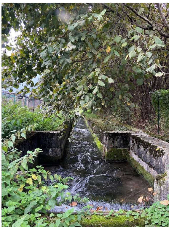
Confluenza Vaso Re nel canale BKW tramite piccolo ponte-canale
