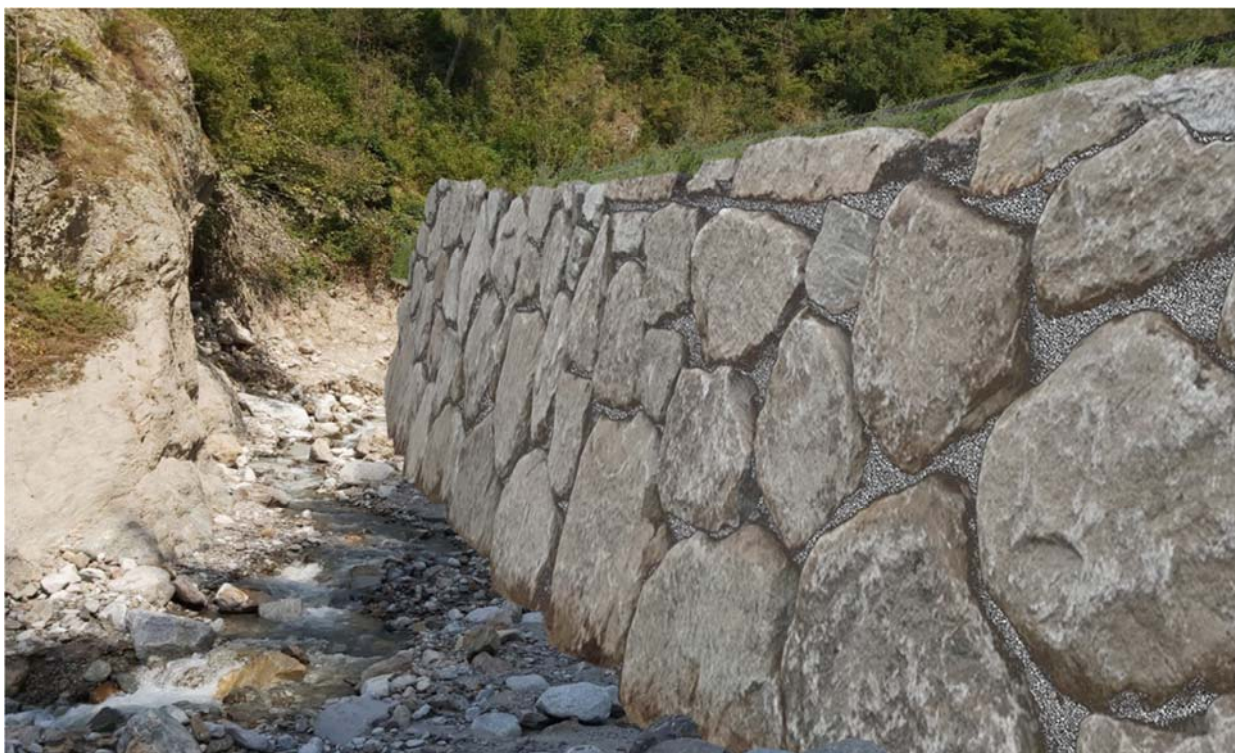
Fig. 2: paramento di scogliera intasata con calcestruzzo
