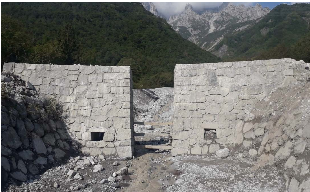
Fig. 1: Rivestimento con paramento ciclopico di strutture in c.a.
