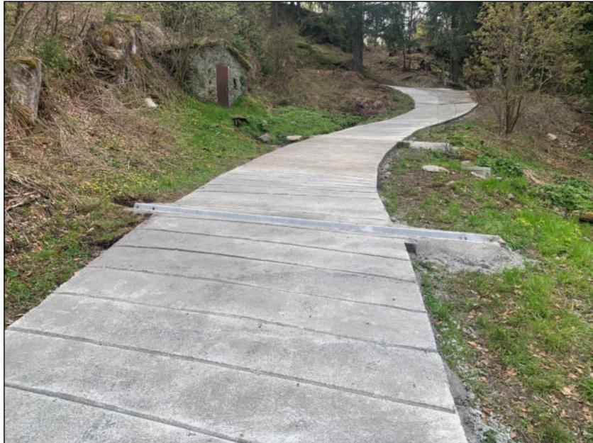
*Immagine tipo del battuto in c.l.s. con canaletta trasversale in profilato metallico*
