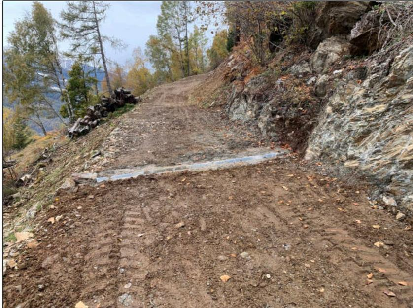
*Immagine tipo della canaletta trasversale in profilato metallico con pozzetto dissipatore*
