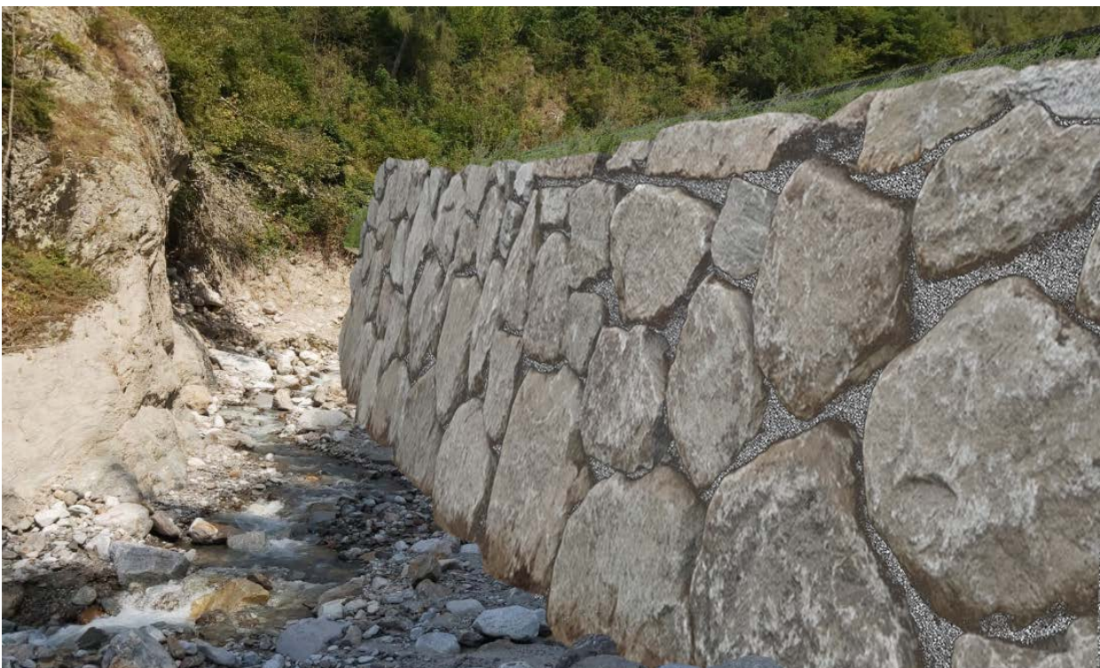
Fig. 2: paramento di scogliera intasata con calcestruzzo
